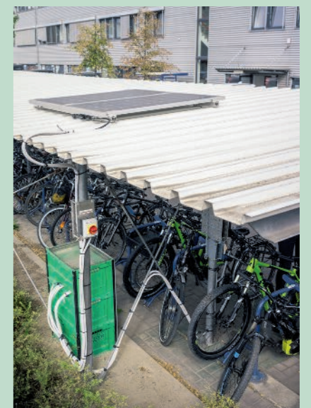
Saft vom Dach: Zwei Solarkollektoren (unteres Bild) versorgen die grüne Ladestation mit Strom. An zwei Steckdosen können DB-Mitarbeiter ihre E-Bikes während der Arbeitszeit aufladen (oberes Bild)
