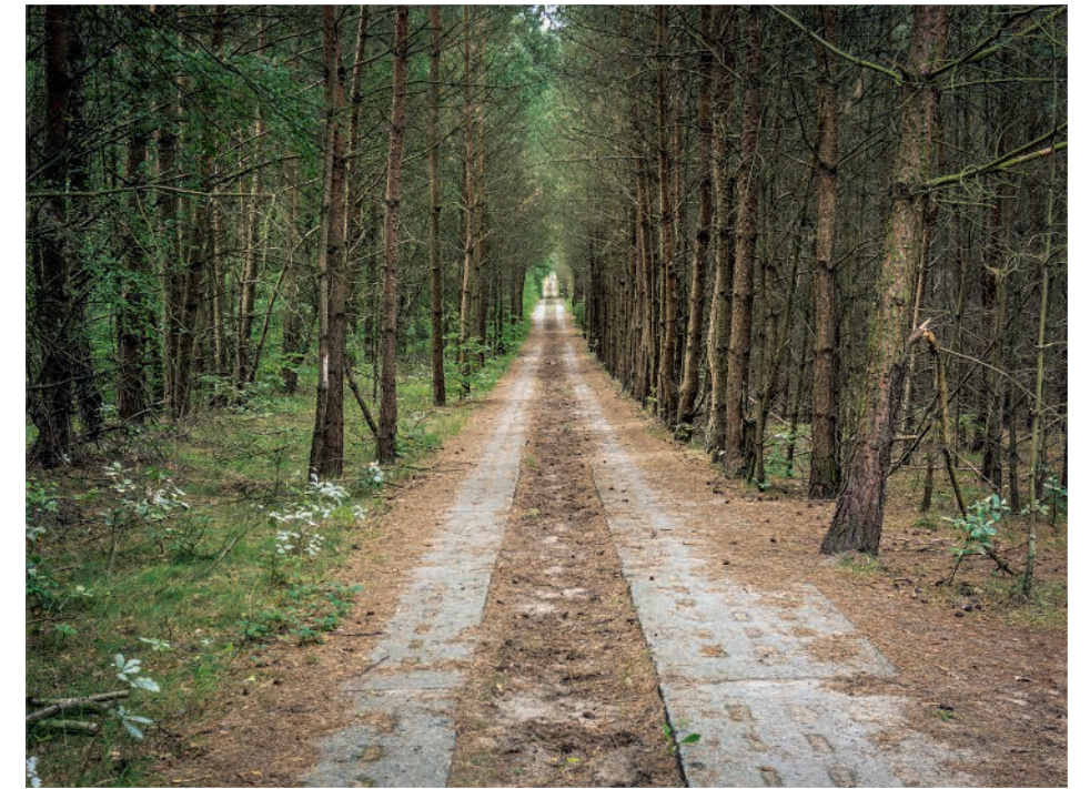
Auf dem Kolonnenweg aus Lochbetonplatten patrouillierten die Grenzposten. Er ist über lange Strecken gut erhalten, so wie hier nordöstlich von Lübeck
