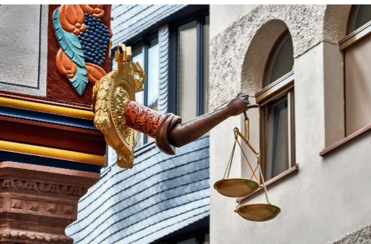
Balanceakt: Inmitten der Stilmischung in der neuen Altstadt ist das Haus Goldene Waage der Hingucker, mit seinen Schnitzereien und einem Blecharm, der aus der Fassade ragt
