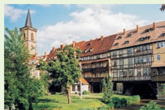
Krämerbrücke in Erfurt
